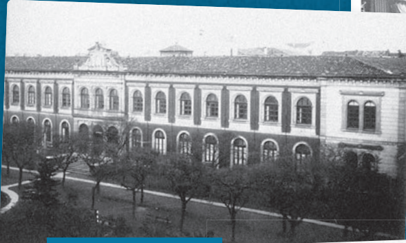
Fachada principal del Instituto (Año 1920).
