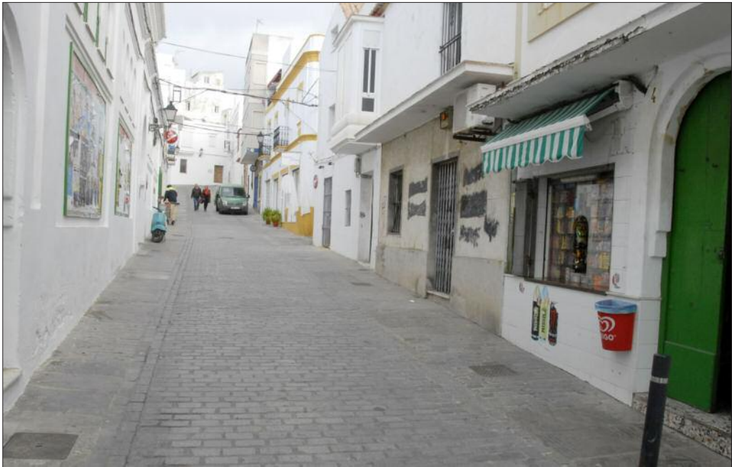
Figura 3.- Vista de la calle Colón, a la altura del mercado de abastos, donde se produjo la contaminación de gasóleo. Foto autor.
