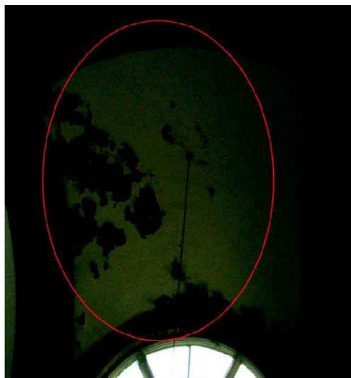
Fotografía 6. Detalle de arco y bóveda de la Catedral de Soatá
