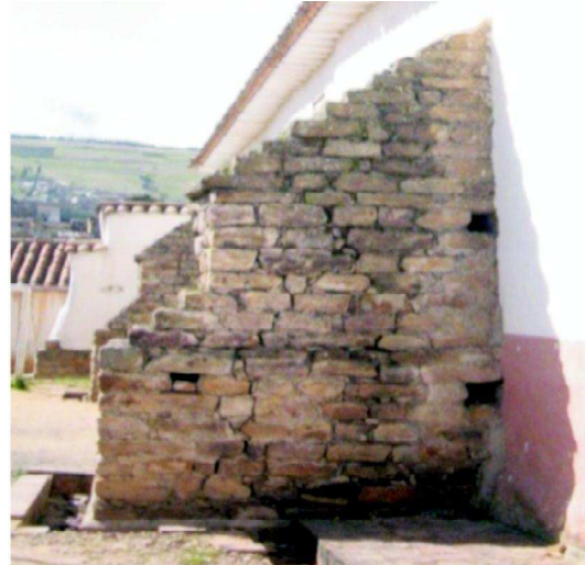
Fotografía 14. Detalle de contrafuerte, iglesia San Laureano (Tunja)
