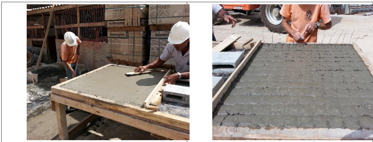
Figura 5 - Processo de produção do espaçador seguindo as instruções da Patente US4147008 no canteiro de obras.
