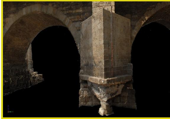
**Fig. 9:** Documentación precisa de la **geometría de la pila nº 2 del puente romano de Lugo**, obtenida con los equipos LiDAR. Detalle de un modelo 3D: se aprecia el estado de socavamiento en el que se encontraba antes de los trabajos de rehabilitación.
