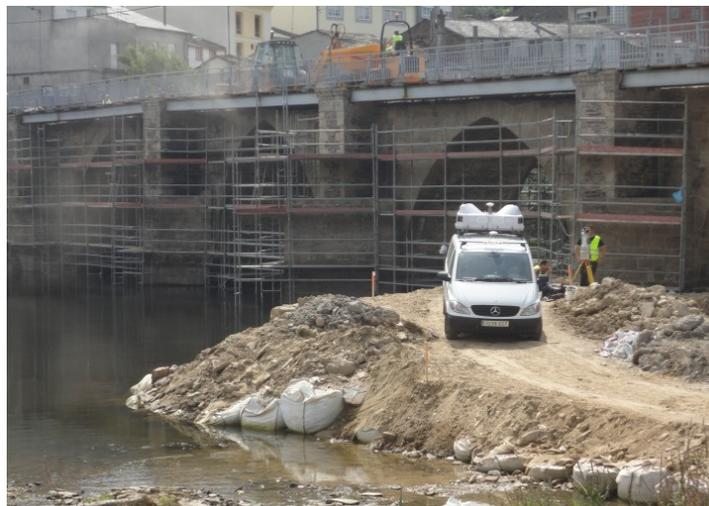
**Fig. 7:** Unidad Móvil SITEGI sobre la ataguía provisional de obra construida en el lecho del río Miño, para las obras de rehabilitación del puente romano de Lugo.
