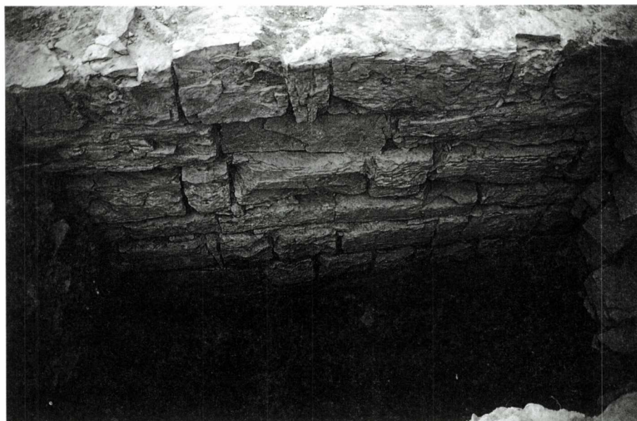
Fotografia 6. Sondeig practicat a la cara externa del mur est on s'aprecia la seva rasa de fonamentació. En aquest punt el mur representa una alçada total de dos metres.
