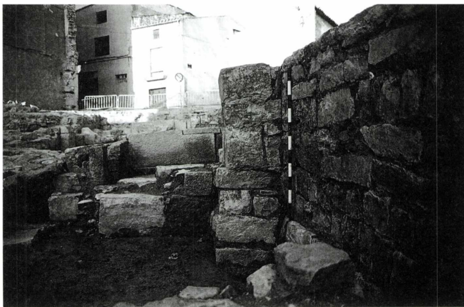
Fotografia 5. Pilar, amb inici d'arc, adossat a la cara interna del mur est de l'edifici medieval.
