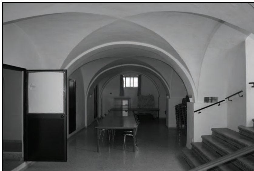
Fig. 3. Vista del pasillo trasversal bajo la sacristía del panteón de la Iglesia de Aznalcóllar (Sevilla).
