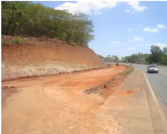
Figura 4 - Uberlândia: obras de duplicação da BR-050, sentido Araguari. Fonte: Oliveira, 2010.
