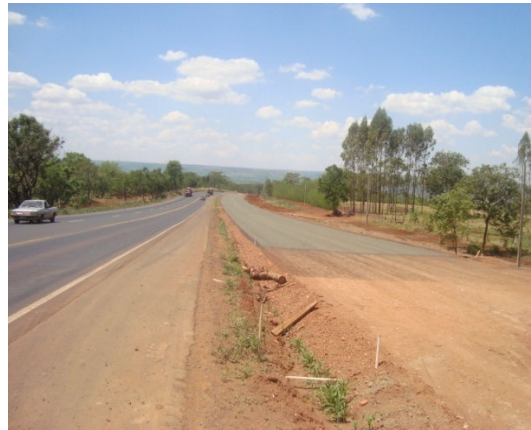
Figura 5 - Uberlândia: obras de duplicação da BR-050, sentido Araguari. Fonte Oliveira, 2010.
