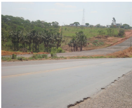
Figura 6 – Uberlândia: obras de duplicação da BR-365, sentido Ituiutaba. Fonte: Oliveira, 2010.
