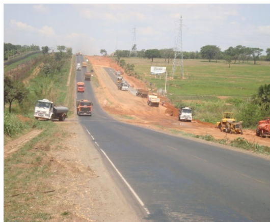
Figura 7 – Uberlândia: obras de duplicação da BR-365, sentido Ituiutaba. Fonte: Oliveira, 2010.
