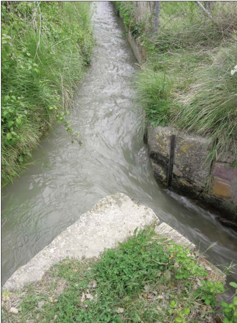
Fig. 1. Partidor en la Cruz del Palmo, en el sistema de riegos del pantano de Arguis.
