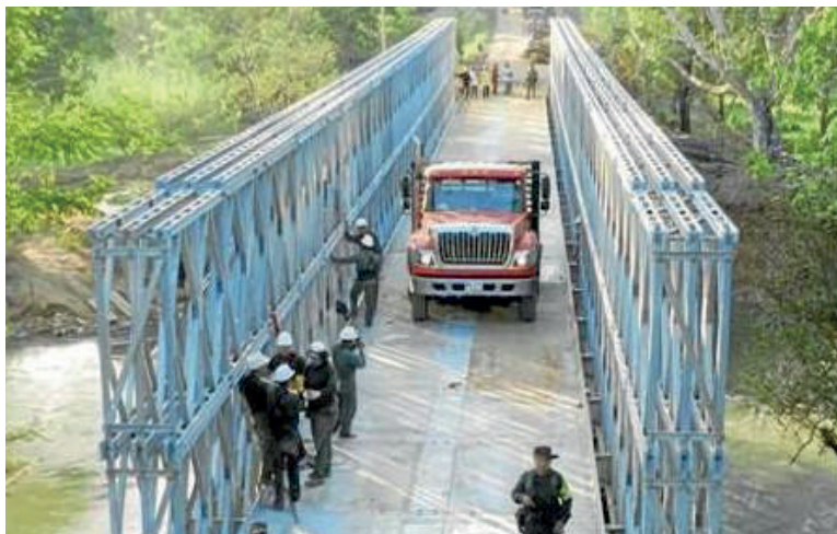
Figura 12. Puente Acrow en configuración triple-doble para remplazar el puente Riecito destruido por grupos terroristas.
