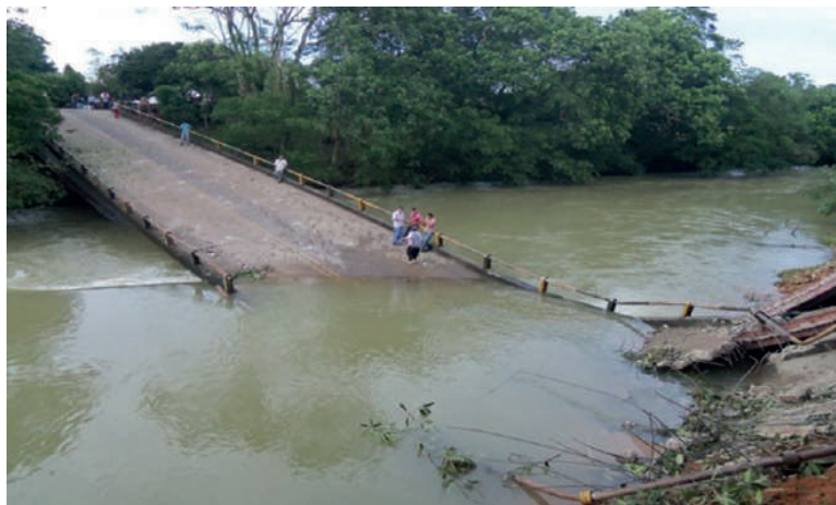
Figura 10. Panorámica lateral del puente Riecito luego del colapso. Fuente: INVIAS, 2012 [11].
