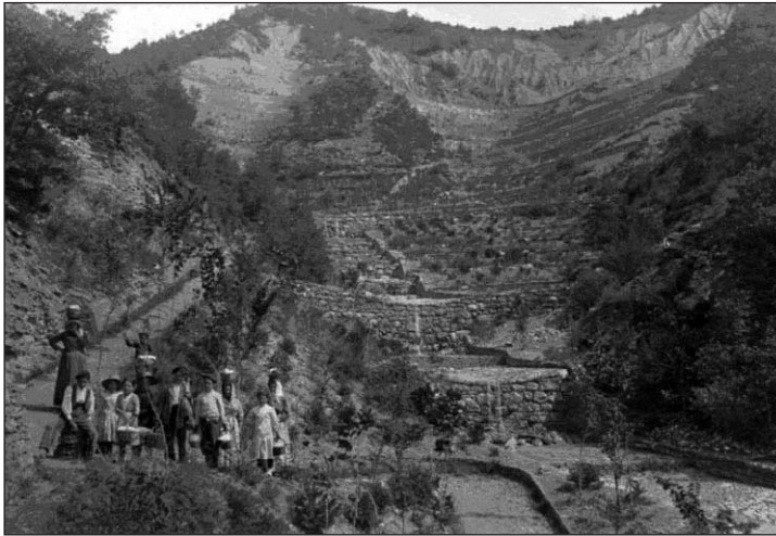
Fig. 12. Torrente de Arratiecho. Corrección del cauce principal terminada y concha de erosión de la margen izquierda. En primer término, familiares de los trabajadores subiéndoles la comida. (Foto: Pedro Ayerbe)
