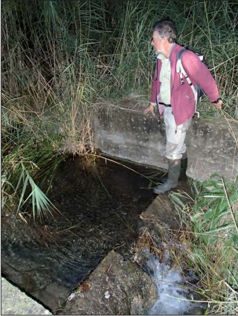
Fig. 4a. Vertedero en el arroyo de Isarre.
