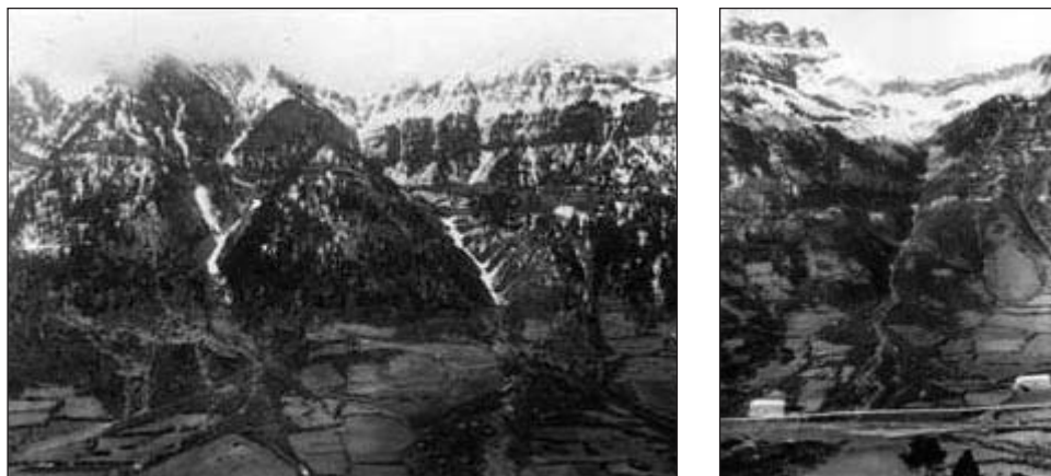
Fig. 22. Vistas de los torrentes de Epifanio y Borreguil de Samán (izquierda) y de Estiviellas (derecha) antes de su corrección, donde se aprecia su extrema torrencialidad y su muy accidentada orografía. La foto de la derecha está fechada en 1912. (Fotos: Benito Ayerbe)
