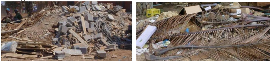
Figura 4: Punto de escombros.
