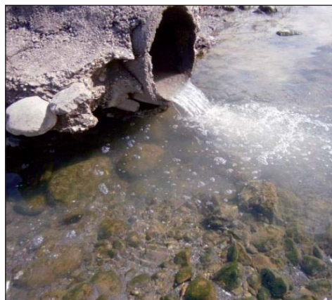
Figs. 11 y 12. A la izquierda, detalle de la tubería al descubierto en El Pueyo durante el muestreo de invierno. Se observó un desarrollo excesivo de algas en torno a su ubicación, así como espumas procedentes del vertido. A la derecha, detalle del color marrón grisáceo del punto de Sabiñánigo en verano.
