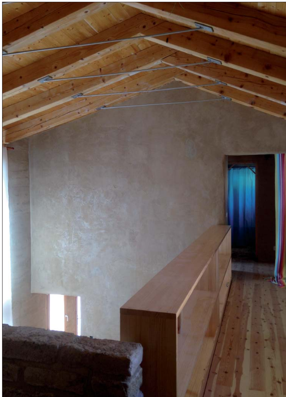
Fig. 2. Interior de la vivienda construida en tapias.
