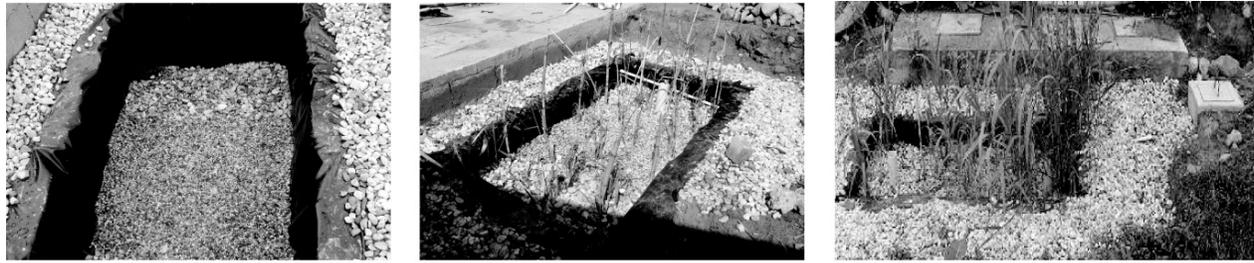
**Figura 6.** Construcción, maduración y tratamiento del humedal de flujo subsuperficial HPSS a escala real, en la vereda El Zango, municipio de Guarne.
