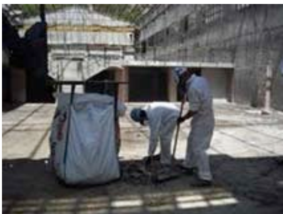
Retirada y limpieza materiales con amianto
