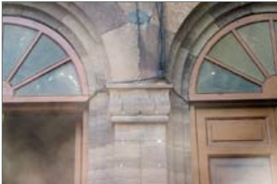
Foto nº 17. Detalle de uno de los pilares de la Casa de Baños
