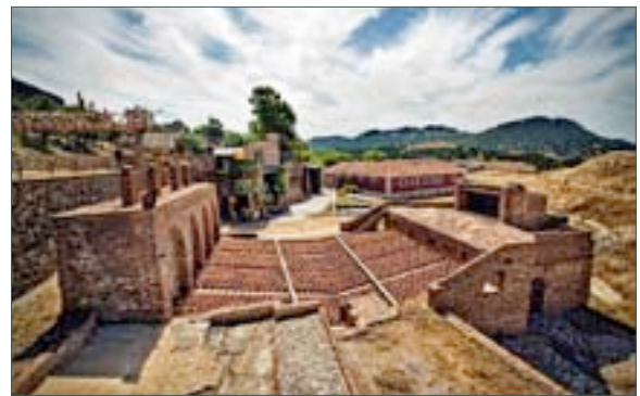
Figura 18. Hornos aludeles en el cerco de buitrones de Almadenejos. (Fuente: Elaboración propia, 2010).
