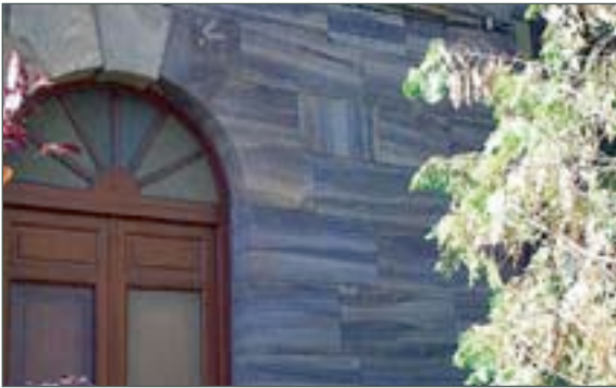
Foto nº15. Piedra arenisca en los dinteles de una de las ventanas de la Casa de Baños
