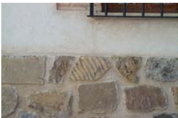
Foto nº 6. Aplacado del zócalo de la Iglesia de la Soledad
