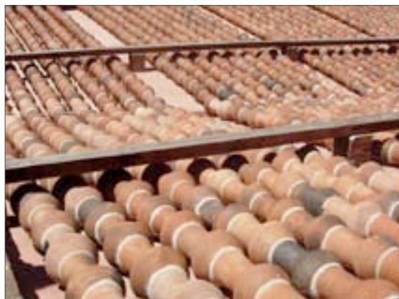
Figura 10. Planes de “cabeza” y “radera” con los postes donde apoya un tablón de madera. (Fuente: Elaboración propia)
