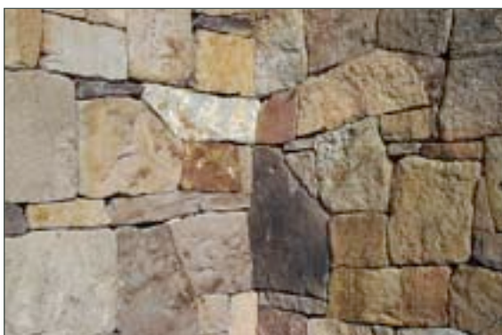
Foto nº 20. Detalle de la mampostería de arenisca de la Iglesia de Santiago Apóstol
