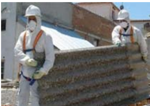
Trabajos de desamiantado
