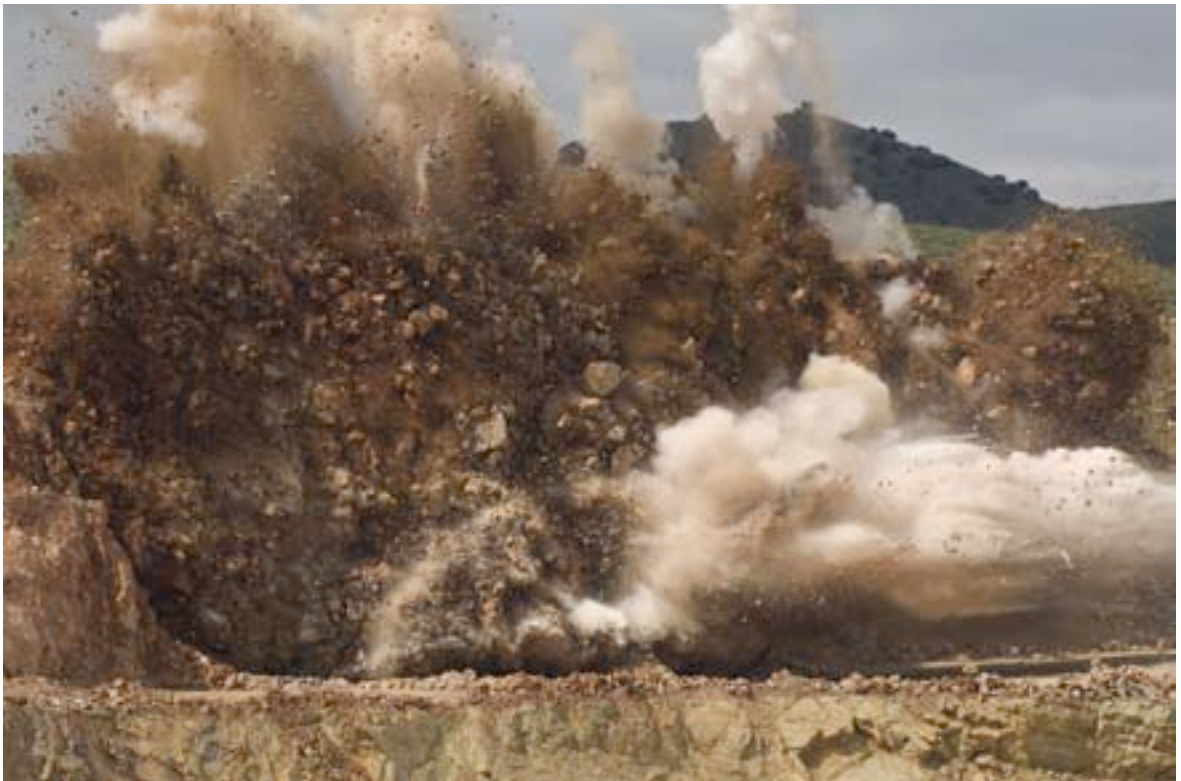
Ejemplo de voladura de grandes barrenos.
