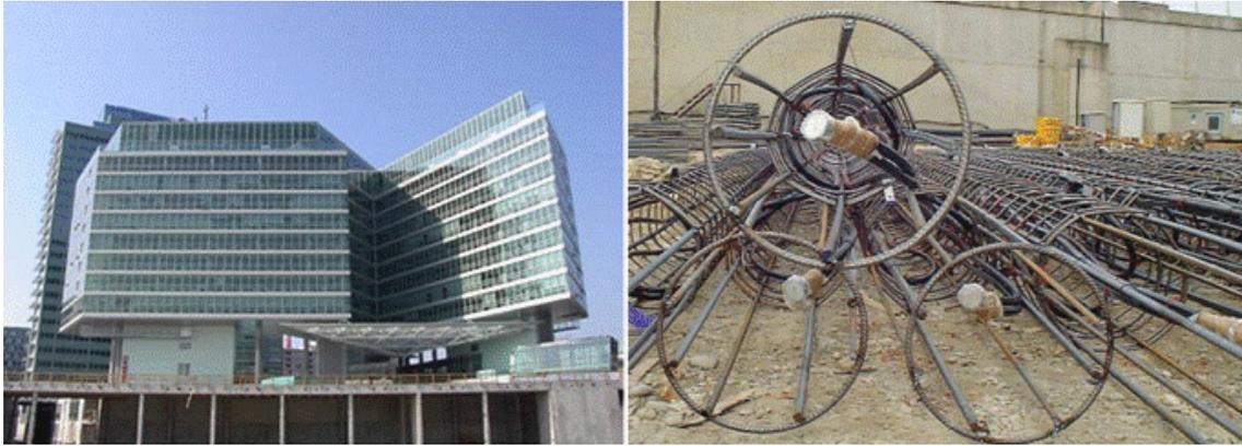
**Figura 8.** Edificio strabag headquarters en Viena (Austria). Aspecto final y pilotes geotérmicos.
