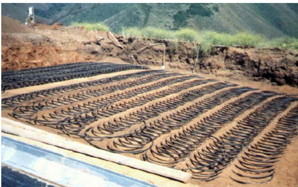
Figura 6. Terreno con colectores horizontales. Fuente: [www.instalacionesalegre.com](http://www.instalacionesalegre.com)
