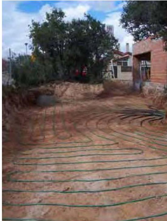
Figura 5. Terreno con colectores horizontales. Fuente: [www.instalacionesalegre.com](http://www.instalacionesalegre.com)
