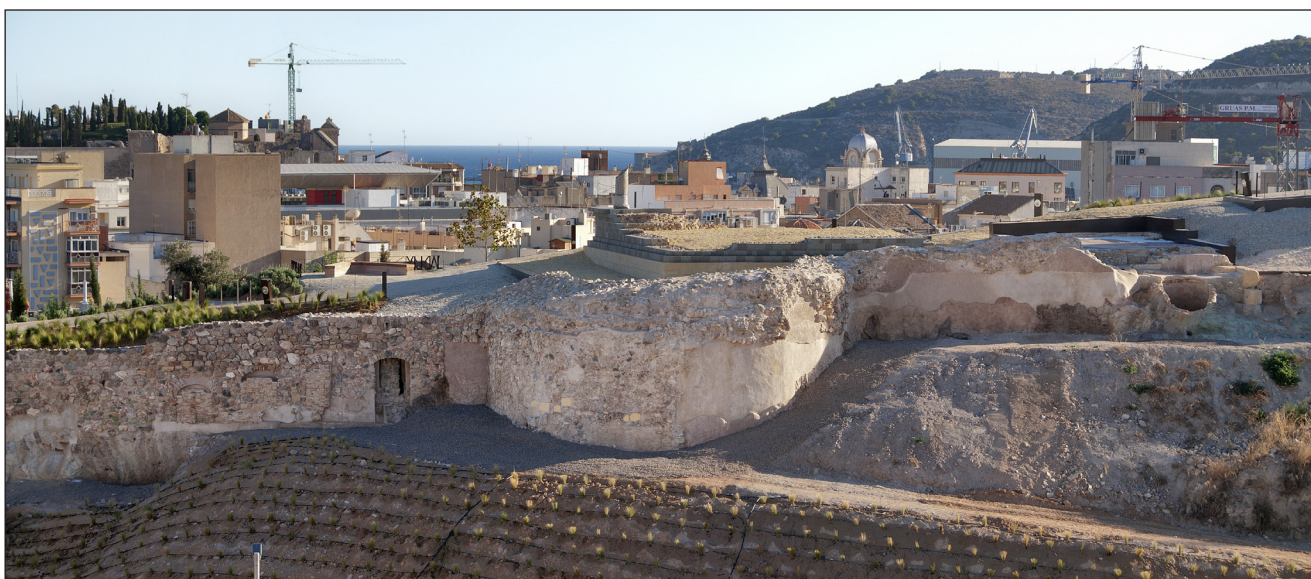
Lámina 10. Cartagena, Molinete. Cubo central del tramo del Molinete de la muralla de Carlos I (fot.: J. Gómez).
