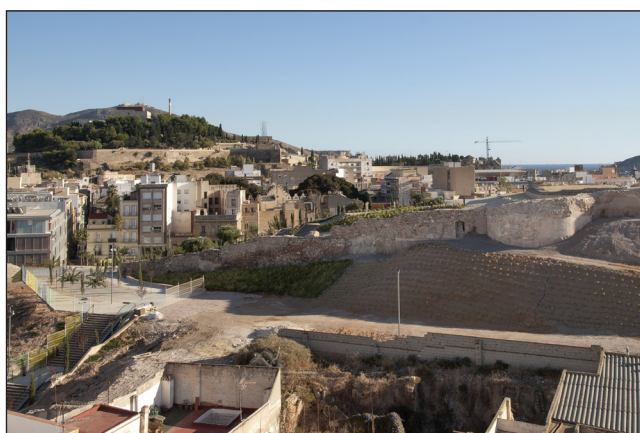
Lámina 5. Cartagena, Molinete. Vista de la cortina muraria entre los cubos oriental y central (fot.: J. Gómez).
