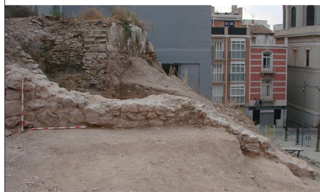
FOTIFICACIÓN DE CARLOS I. LIENZO TRAMO CALLE ADARVE EN LA UNIÓN CON EL CUBO ORIENTAL. ALZADO INTERIOR
