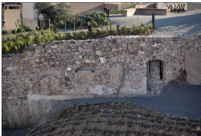
Lámina 9. Cartagena, Molinete. Detalle de las reparaciones y estructuras adosadas a la fachada exterior de la cortina muraria de la muralla de Carlos I entre los cubos oriental y central (fot.: J. Gómez).
