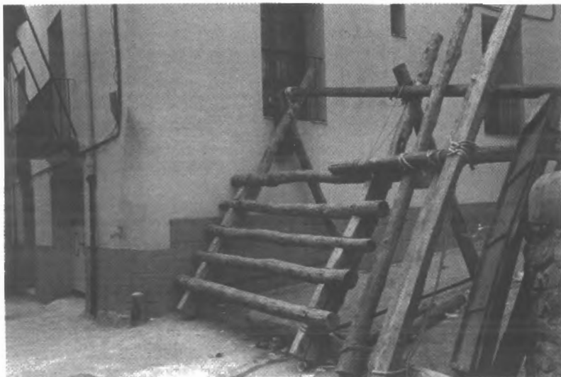
Fig. n.º 7.- Fiestas populares de toros del Alto Palencia y Sierra de Espadán. (Castellón). Disposición de las barreras. Hasta hace pocos años, estas barreras se constituían, como indica la ilustración, con troncos de árboles y traviesas que se sujetaban con cuerdas y que formaba una especie de escalera por la que se podrá trepar. (Fot. de M a Dolores Vargas).
