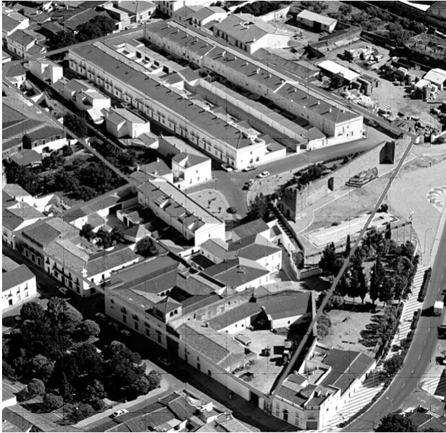
Fig. 2: fotografía actual del área que ocupaba el Palacio de los Zapata
