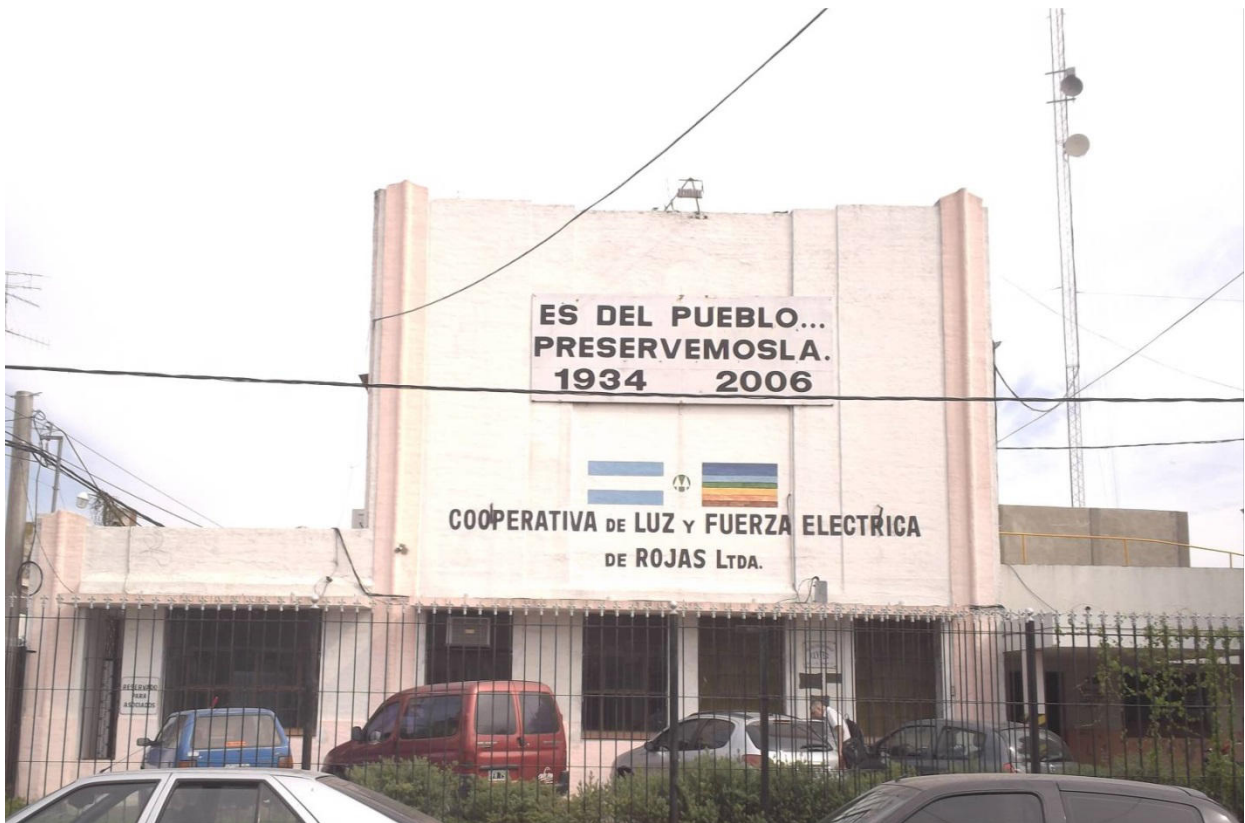
Foto N° 2 Cooperativa de luz y fuerza eléctrica de Rojas.
