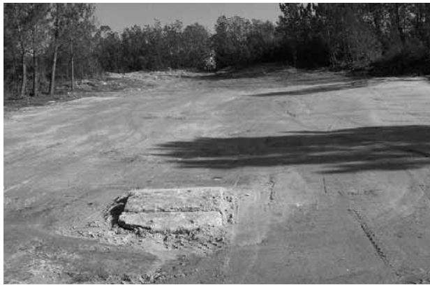
Figura 6. Muestra de un campo de bolos de Boiro. En la imagen, obras de remodelación del campo de bolos de Triñáns. Fuente: elaboración propia.
