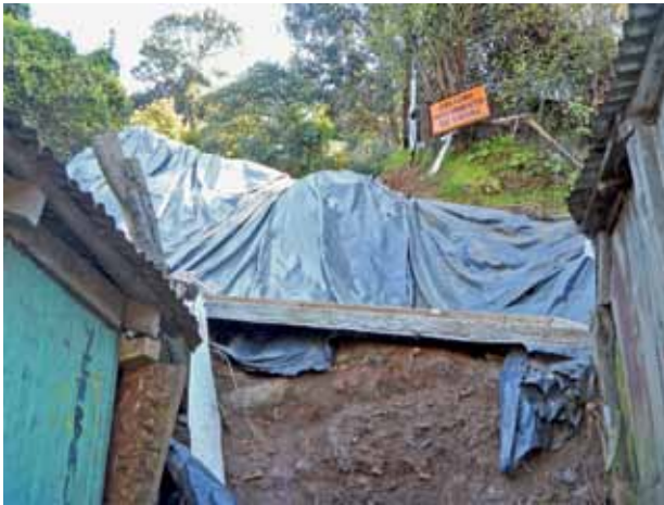
Figura 4. a) Viviendas afectadas por deslizamiento rotacional; b) Ladera intervenida y desestabilizada por remoción del terreno. Fotografía del autor, septiembre del 2012.
