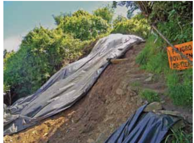
Figura 4. a) Viviendas afectadas por deslizamiento rotacional; b) Ladera intervenida y desestabilizada por remoción del terreno. Fotografía del autor, septiembre del 2012.
