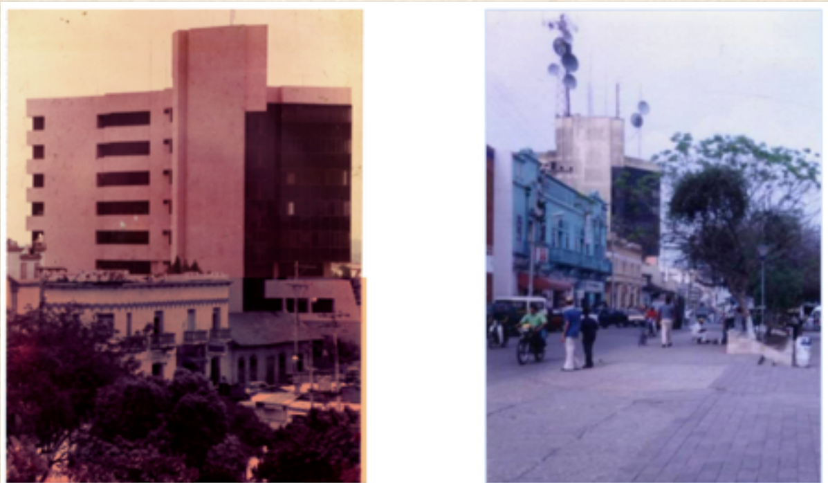
Fig. 62 y 63 Edificio Lotería La Sabanera y su entorno, Sincelejo. 1979. Fuente: Archivo Arturo Hernández Gómez
