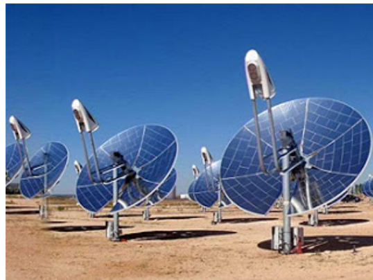
Figura 12. Discos parabólicos con motor Stirling [30]. Concentra la radiación entre 1000-4000 veces. Potencias unitarias de 5 a 25 MW. Temperaturas de hasta 1500 °C.
