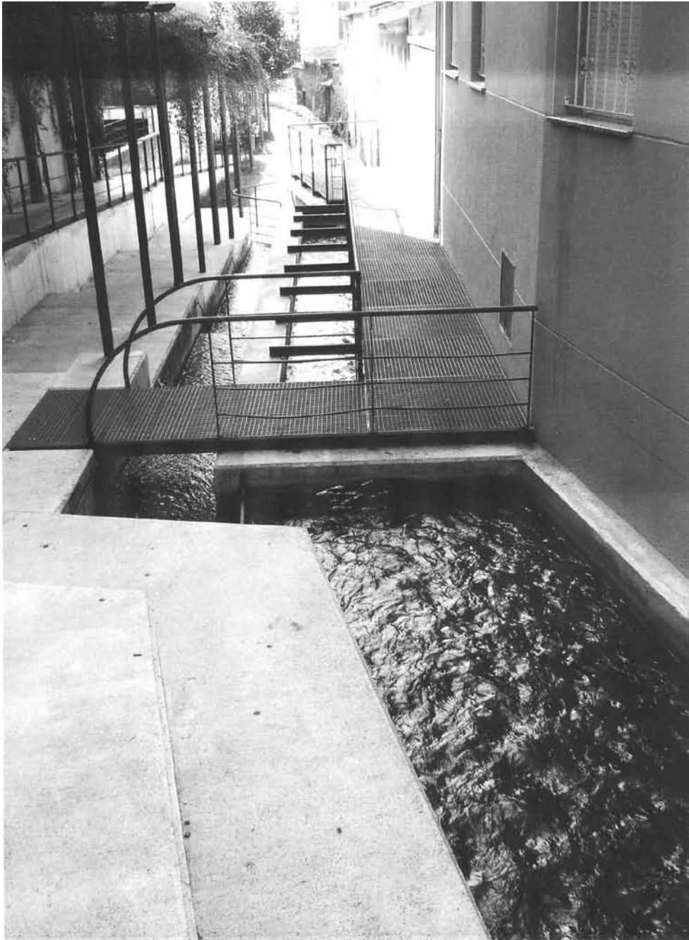
Figura 14 Intervenció arquitectònica que reconstrueix el sistema hidràulic d'un antic molí amb el canal principal, el de desguàs i el salt d'aigua.
