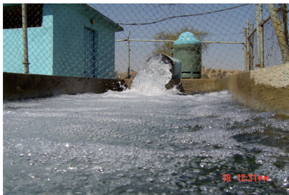
Figura 2. Pozo profundo. Figure 2. Deep well.
