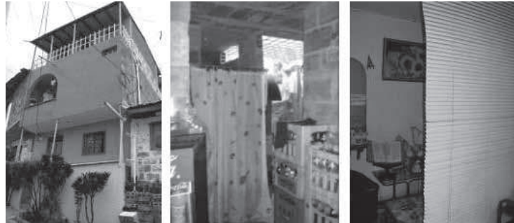
Imagen 2. Fachada y divisiones al interior de la vivienda
