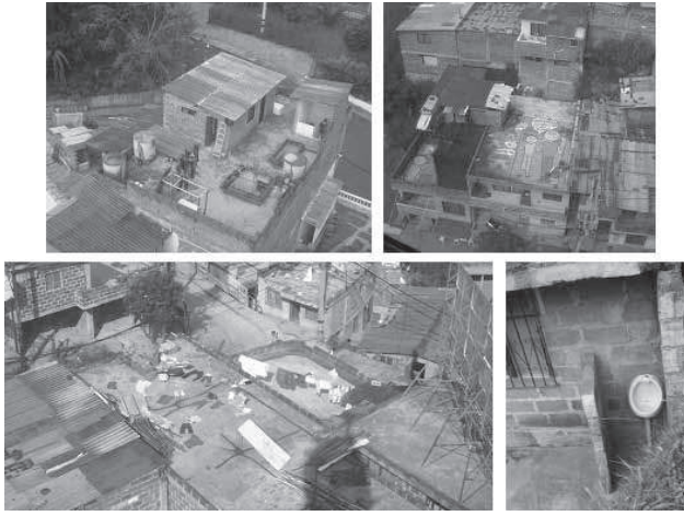
Imagen 4. Usos cotidianos de las terrazas estas actividades se han modificado con la aparición del Metrocable
