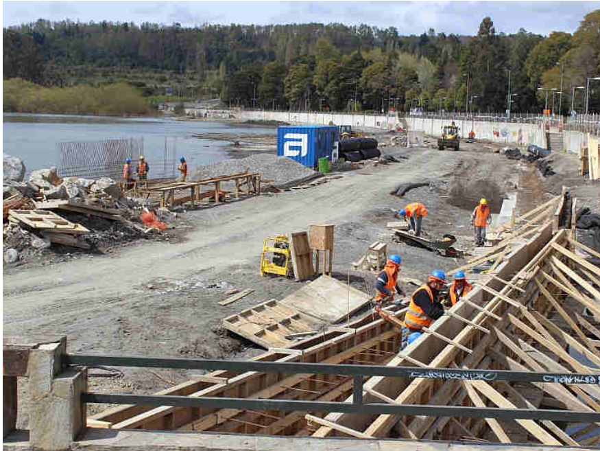
Figura 3: Construcción Playa Pucara, borde lago Villarica, comuna de Villarica.
