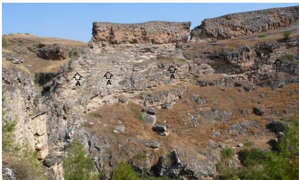
Fig. 5. I resti della strada a nord del ponte inglobati nel calcare: A, lastricato; B, muro di sostruzione.
