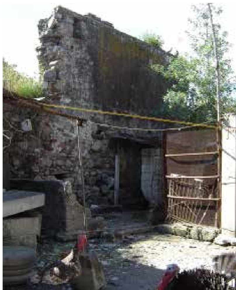
Figuras 5. Vista de restos arquitectónicos. ® González.
