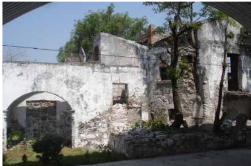
Figura 16. Vista del interior de la escuela primaria "Profesor Raúl Isidro Burgos". ® González.
