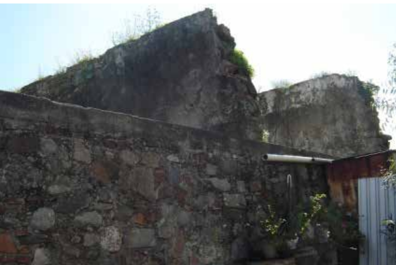
Figuras 4. Vista de restos arquitectónicos. ® González.
