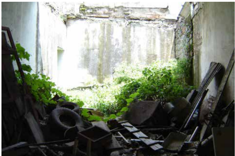
Figuras 42. Vistas de los espacios en abandono del ex Rancho San José el Chico. © González.
