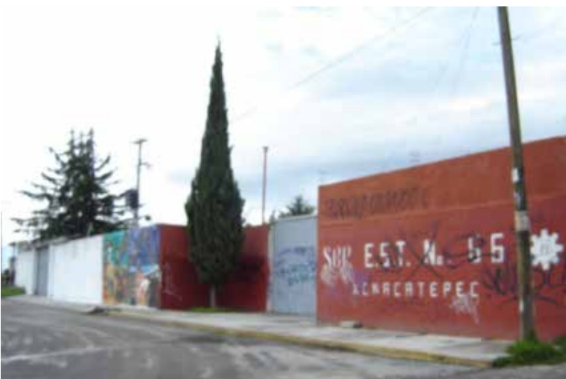
Figura 8. Vista de la fachada de la Escuela Secundaria. ® González.
