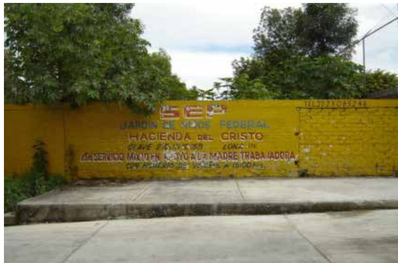
Figura 15. Vista de la fachada del jardín de niños Federal "Hacienda del Cristo". ® González.
