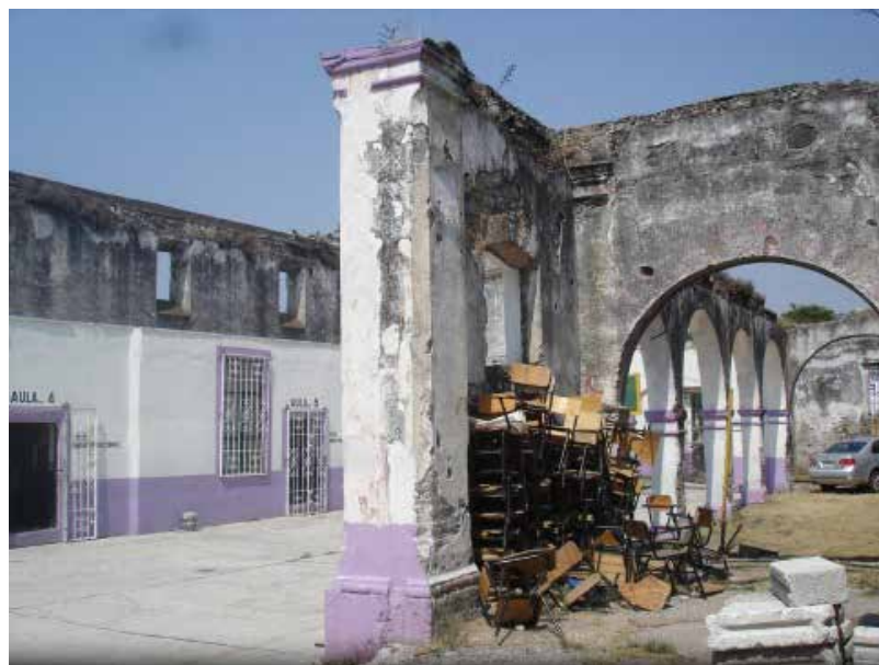
Figuras 39. Vista de los espacios de la ex Hacienda del Cristo adaptados a las necesidades del nuevo uso. Se aprecia la capilla adaptada como auditorio de la escuela. ® González.
