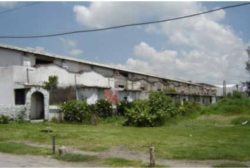
Figura 31. Vista de la calpanería. © González.
