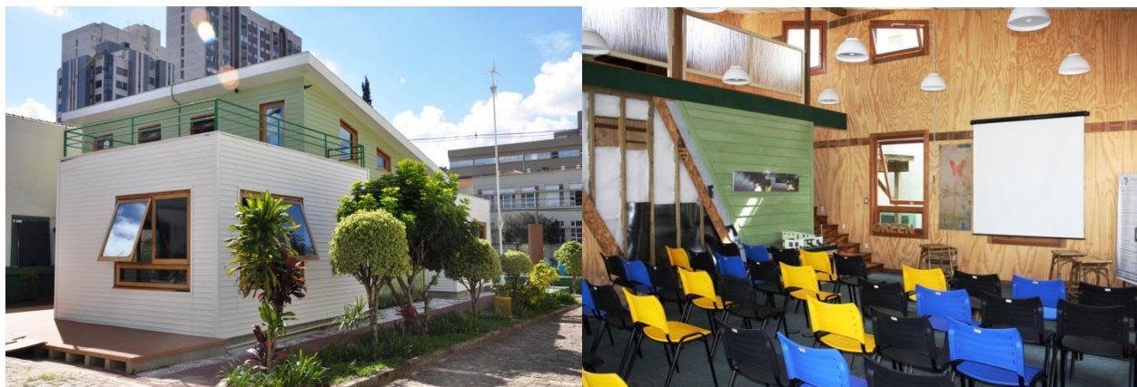
Figura 1: Izquierda: Vista externa de la Oficina verde. Derecha: Vista interna de la Oficina verde. Figure 1: Left: External view of the Green Office. Right: Internal view of the Green Office.
