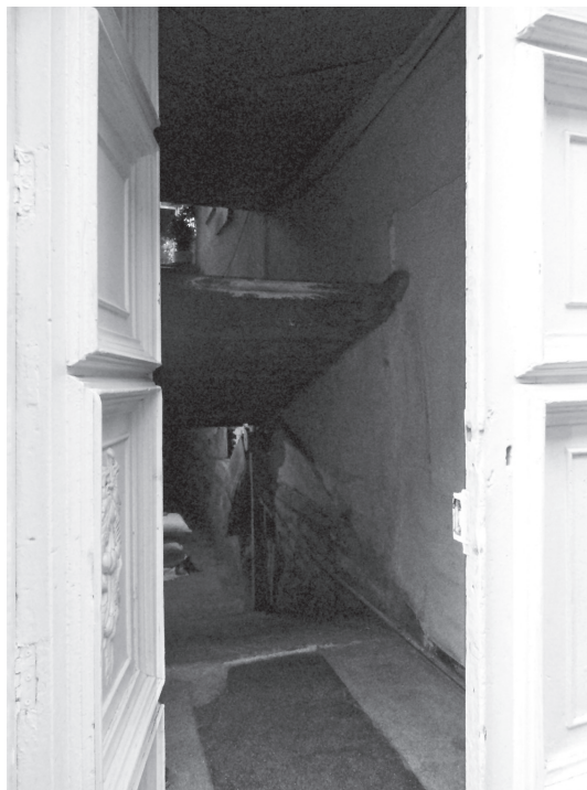
Figura 2. Vista desde la calle: escalera izada que permite el paso debajo de ella. Casa Mercedes Dávila. Aguadas, Caldas
