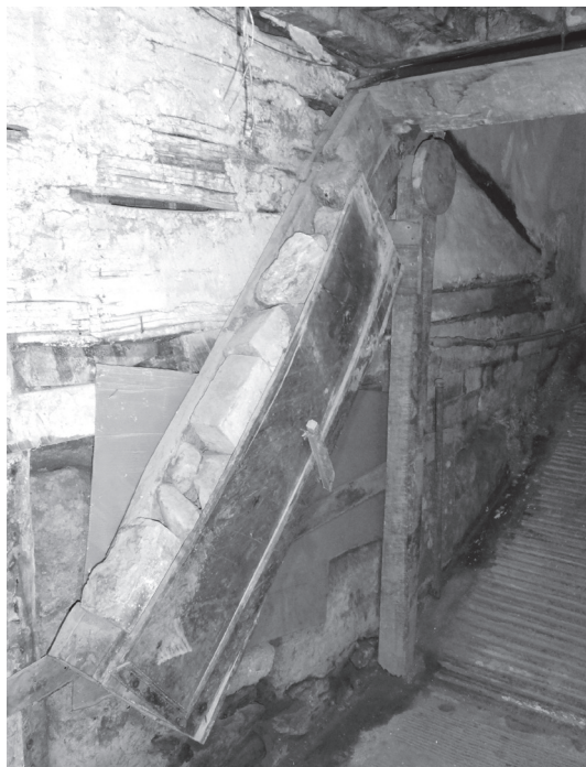
Figura 13. Contrapeso de cajón de madera. Un cajón de madera alberga adobes de arcilla que funcionan como lastre para que la escalera se ponga en funcionamiento, Aguadas, Caldas
