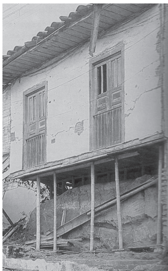
Figura 5. Ganando un piso. Gracias a lo liviano del bahareque se ganó un piso hacia abajo. Fuente: tomado de Robledo Castillo, La ciudad en la colonización antioqueña , 80
