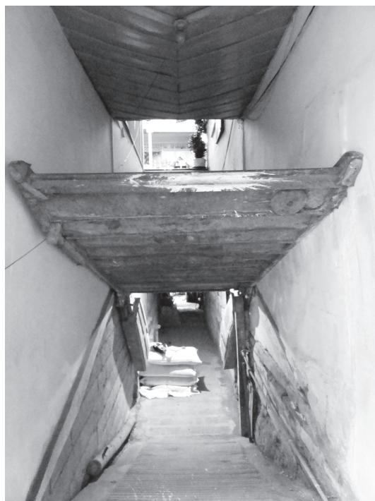
Figura 10. Escalera pivotante abierta: vista desde el acceso. Se puede ver el pasillo hacia el interior de las bodegas, y en la parte superior, el vestíbulo y la marquesina. Casa de Mercedes Dávila Aguadas, Caldas
