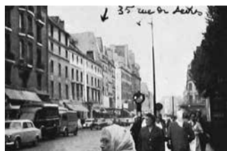
Figuras 3 y 4. La puerta principal del atelier 35 rue de Sèvres desde la calle y la fachada del atelier desde el jardín. Bonjour, monsieur Le Corbusier (1988)
