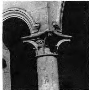
Fig. 169. Detalle columna acceso. Ormpello 466.
