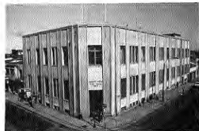
Fig. 183. Edificio Diario El Sur, Concepción.
