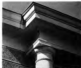
Fig. 159. Detalle de columnas, San Martín 980.
