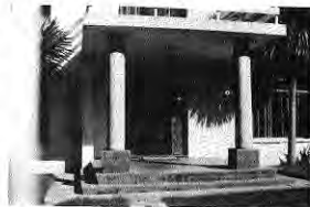
Fig. 174. Columnas de acceso, Freire 1082, interior, Concepción.
