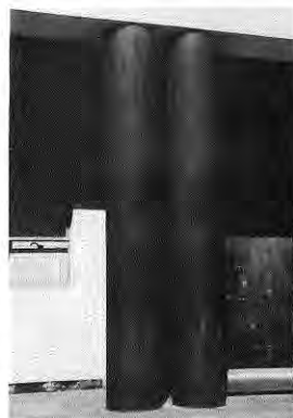
Fig. 202. Detalle columnas de acceso, Instituto de Biología.
