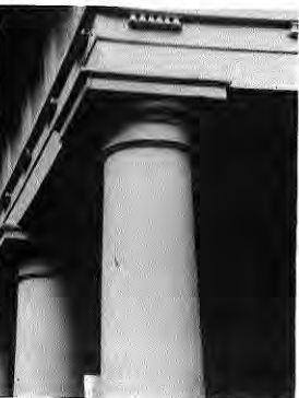
Fig. 173. Detalle columnas, Anibal Pinto 130.
