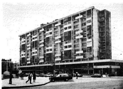
Edificio Tucapel en Concepción.
