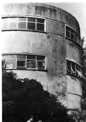
• Detalle Escuela de Educación. Arquitecto Enrique San Martín, 1935-37.
