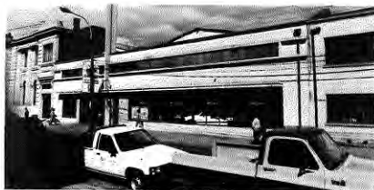
* Fachada continua en la trama urbana central de Concepción.
