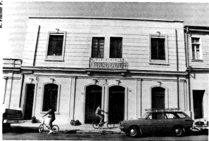
Casa de altos en calle Ongolmo, entre Freire y Maipú.
