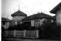
Fig. 5. Vivienda en Avda. Alemana, Temuco.
