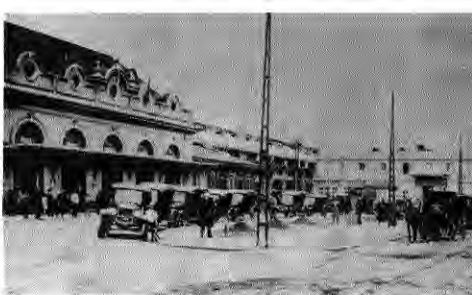
Fig. 3. Antigua Estación de Ferrocarriles de Temuco, hacia 1900. Foto archivo diario Austral.
