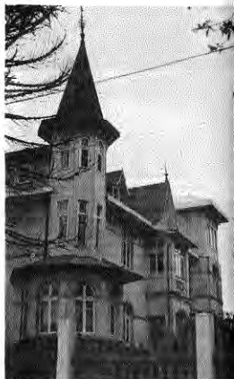
Fig. 4. Actual Casa Central de la Universidad Católica de Chile, sede Temuco.
