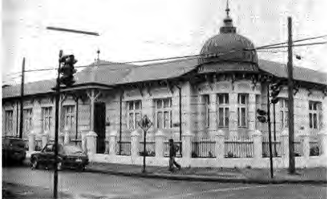
Fig. 6. Bulnes esquina Bello, Temuco.
