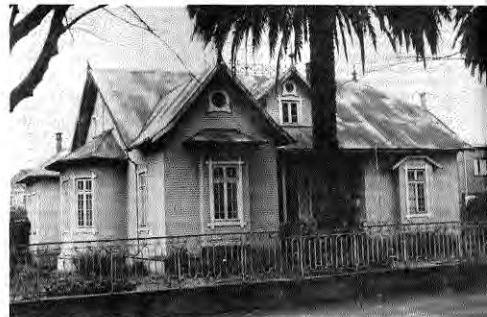
Fig. 3. Vivienda en Avda. Alemania, Temuco.
