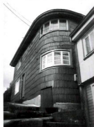
Muro curvo y ventana de esquina, Arqueón, Puerto Montt.
