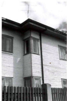
Ventana de esquina, Río Bueno
