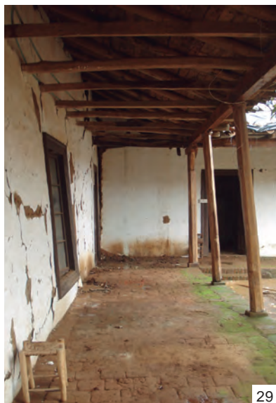
Figura 28 Desplazamiento de los pilares de las basas de apoyo después del terremoto. Foto: Claudia Torres / Figura 29 Corredor y recinto interior de la Casa Parroquial con desaplomes evidentes después del terremoto. Fotos: Claudia Torres / Figura 30 Sentido religioso de la comunidad que busca mantener la tradición y los rituales en torno al espacio de culto. Fotos: Soledad Valdivia
