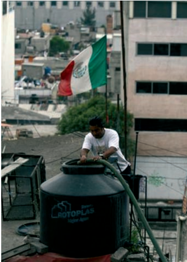
Estanque de acumulación de agua en techumbres. Ciudad de México.
