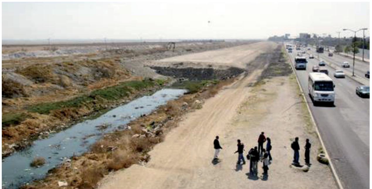
Canalización de escurrimiento de agua en paralelo al desarrollo de la vialidad, próximo a la Ciudad de México. Agentes sociales conociendo el proyecto.
