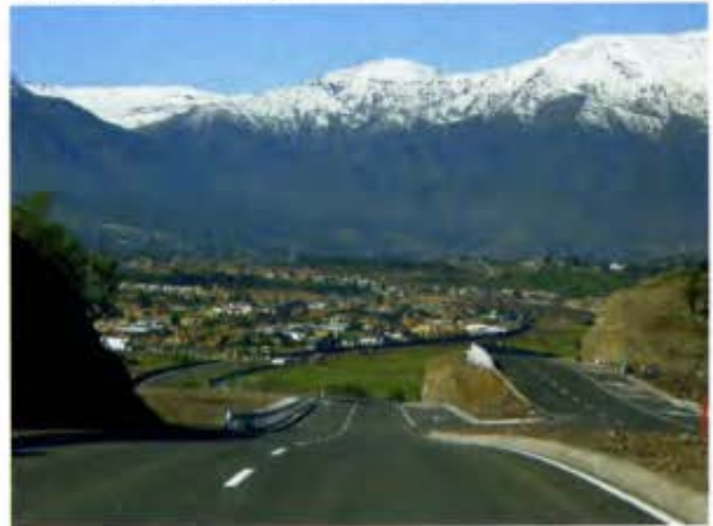
La autopista Pie Andino, ayer privada y hoy de libre tránsito.
