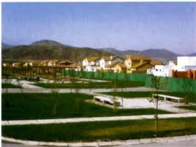
Figura N°2. Viviendas en las ZODUC de Piedra Roja y La Reserva.
