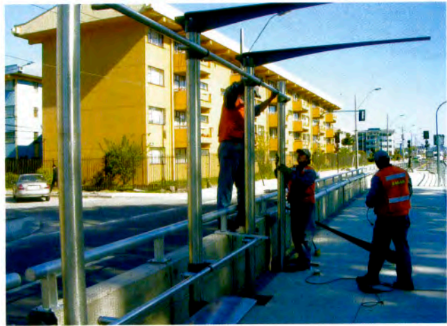
Trabajos de terminación de los refugios peatonales del proyecto Biovías.
