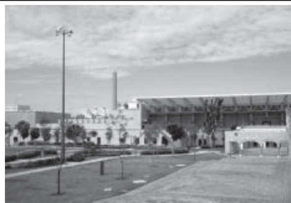
Figura 4. Pérdida de proporción y perspectiva del Chacuaco.
