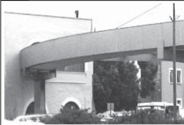
Figura 7. Desembarque del puente peatonal a las Oficinas del fideicomiso.
