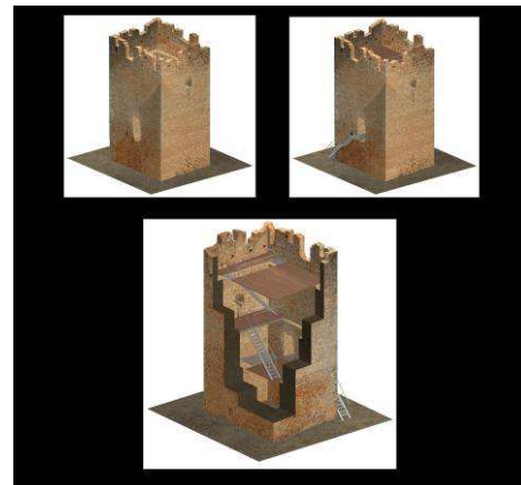
Figura 17. Imagen virtual reconstrucción de la intervención en la torre de Piqueras del Castillo. RUIZ – CRISTINI. 2009
