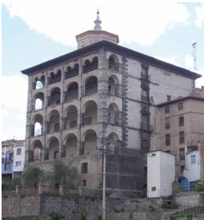
Lám. 6. Palacio del marqués de Casa Torre. Fachada posterior
