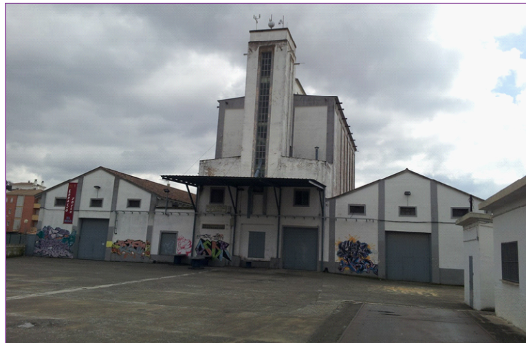
Imagen 2. Silo de Alcalá la Real. Exterior
