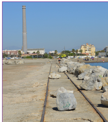
5. Chimenea térmica San Patricio
