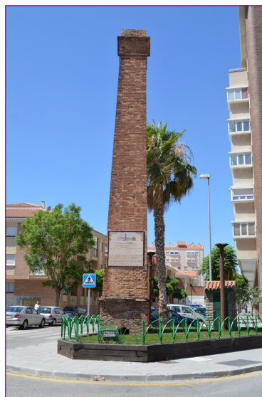
4. Chimenea de la fundición de cayetano ramírez.
