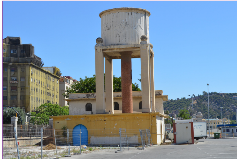
2. Depósito o torre de agua. Puerto de Málaga.
