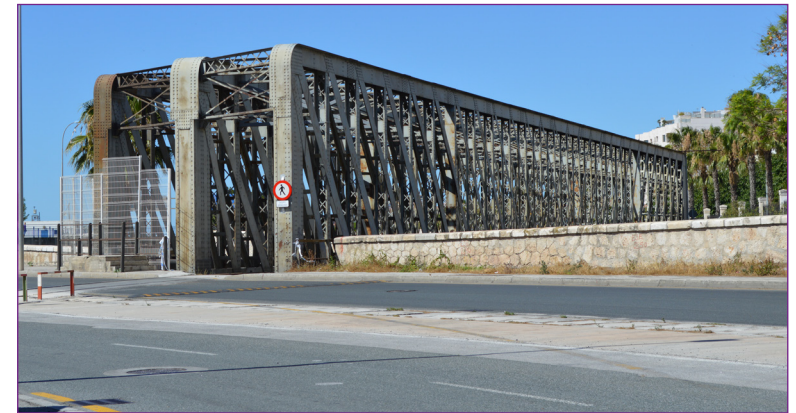
3. Puente de hierro sobre el Guadalmedina.
