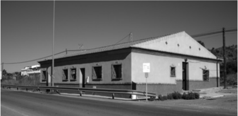
14.- La Venta de San Cayetano, recientemente restaurada, era paso obligado para los viajeros del camino de la Escaleruela y de Boca del Asno
