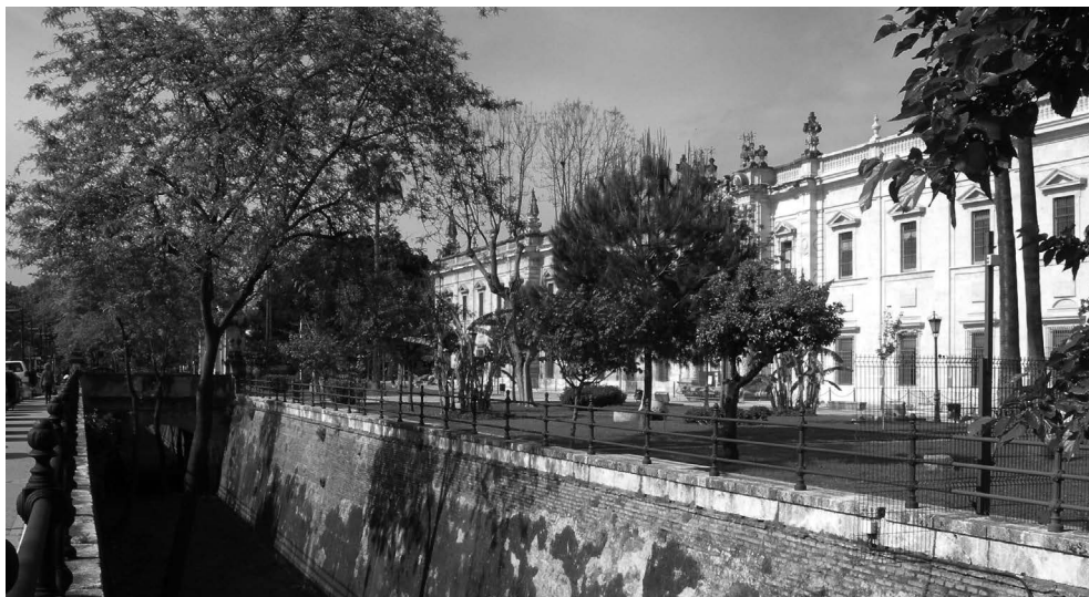
Vista del costado oriental del foso de la Real Fábrica de Tabacos, cuyas obras de los laterales de levante y poniente dirigió como aparejador Antonio de Figueroa en tres fases: la primera, entre el 2 de junio y el 15 de octubre de 1762. Posteriormente lo haría del 24 al 31 de mayo de 1764 y desde el 16 de junio hasta el 15 de octubre de ese año, fecha en que quedaron finalizados ambos costados. Según consta de las certificaciones de obra, Figueroa simultaneó su trabajo aquí y en los Reales Alcázares. El maestro asentista fue Francisco Sánchez de Aragón, documentándose a Miguel de Losilla, maestro cantero cuñado de Antonio de Figueroa, en la construcción de las garitas de piedra. Fotografía del autor.
